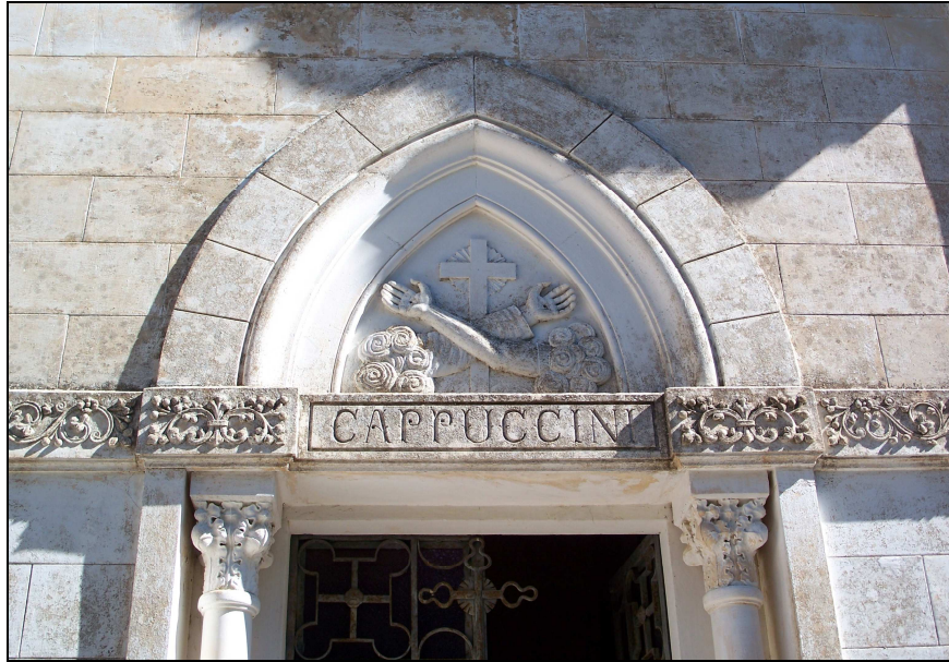
La cappelletta realizzata dai padri Cappuccini: particolare del prospetto con la simbologia francescana
