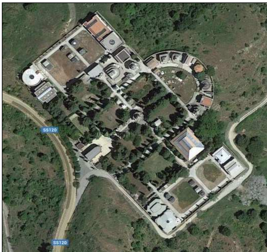
Veduta satellitare del civico cimitero di Troina: ai due estremi laterali le nuove aree di espansione
